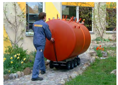
Auf Wunsch: Mithilfe beim Einbringen und Isolieren des Speichers auf der Baustelle
