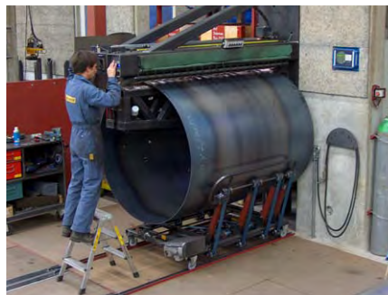
Die Längsschweißnaht wird automatisch ausgeführt
