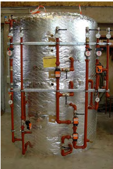
Glaswolle alubeschichtet mit Maschengitter
