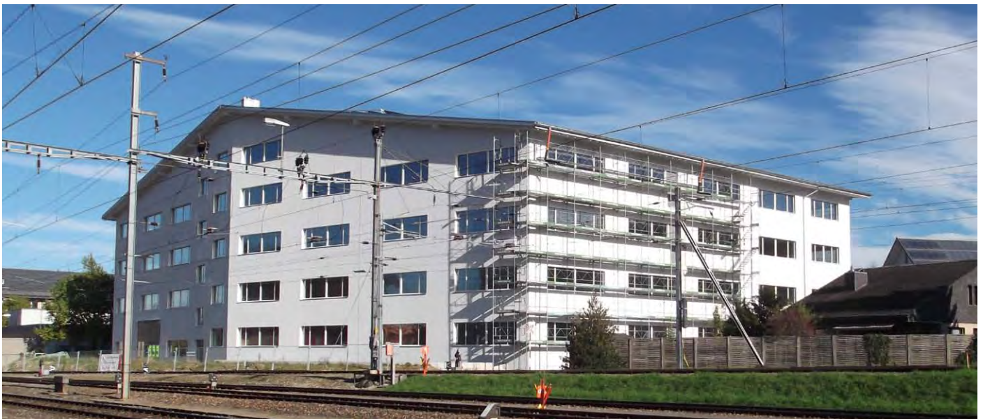
Wir erhöhen unsere Kapazitäten: Neubau Speicherproduktion, CH-Oberburg. Bilder: www.jenni.ch .
