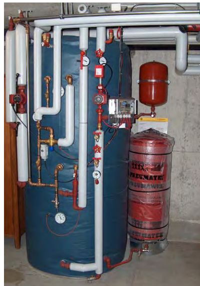
Glaswolle oder Schaumstoff mit Kunststoffhülle (Brandklasse III oder V)
