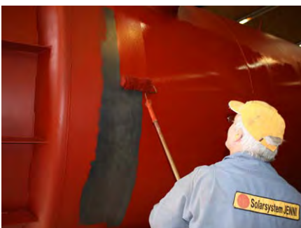
Anbringen der Rostschutzgrundierung
