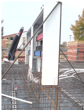
verteilerfixierung durch den betonbauer
