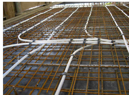
rohrfixierung auf der oberen bewehrung
